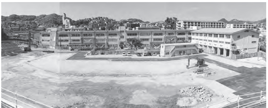
改築工事中西町小学校
