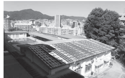
高尾小学校プール、給食室棟施設
