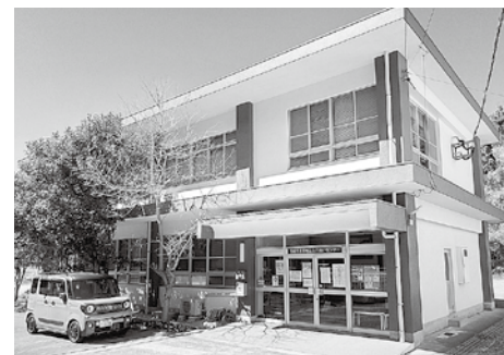
手熊地区ふれあいセンター、エレベーター新設等工事
