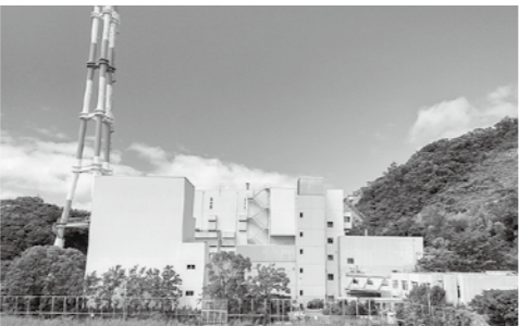
工場棟内部改修ほか主体工事(工期は令和6年1月19日まで)、煙突解体工事(工期は令和4年7月29日まで)が行われる旧西工場!
