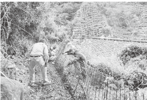
イノシシ侵入防止のワイヤーメッシュ柵設置!
