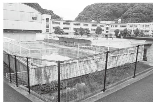
解体工事が行われる西浦上小学校のプール
