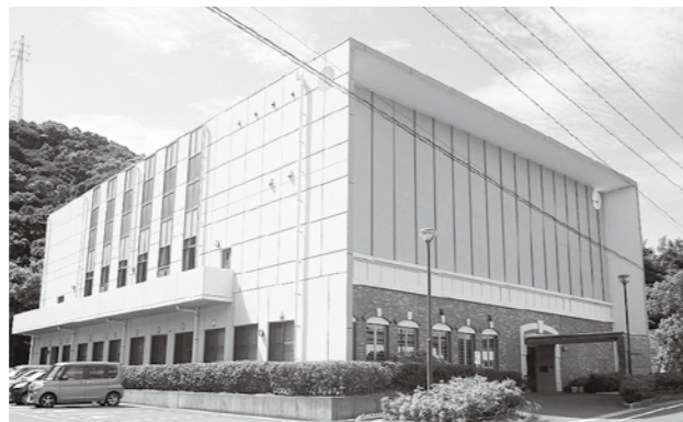
南部市民センター
