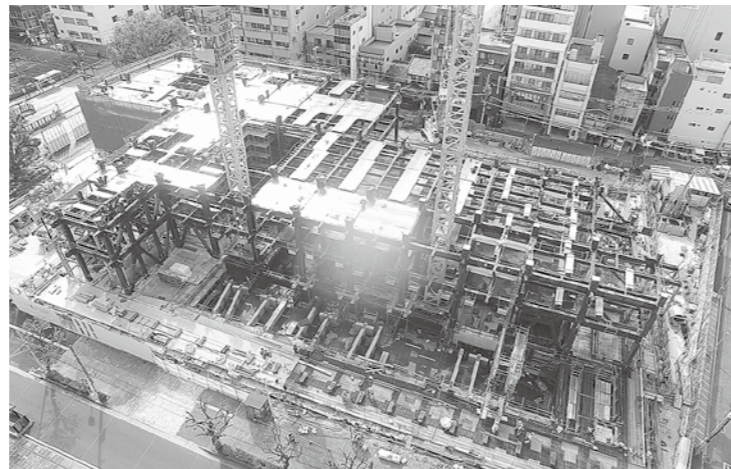
令和4年度完成予定の公会堂跡地に建設中の「新庁舎」
