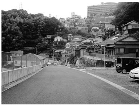
防災・居住環境など改善が図られた水の浦地区
