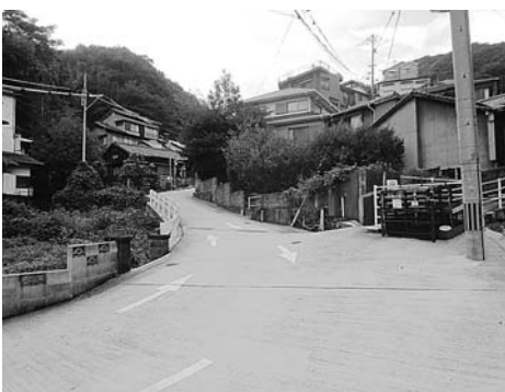
飽の浦地区の車みち整備事業
