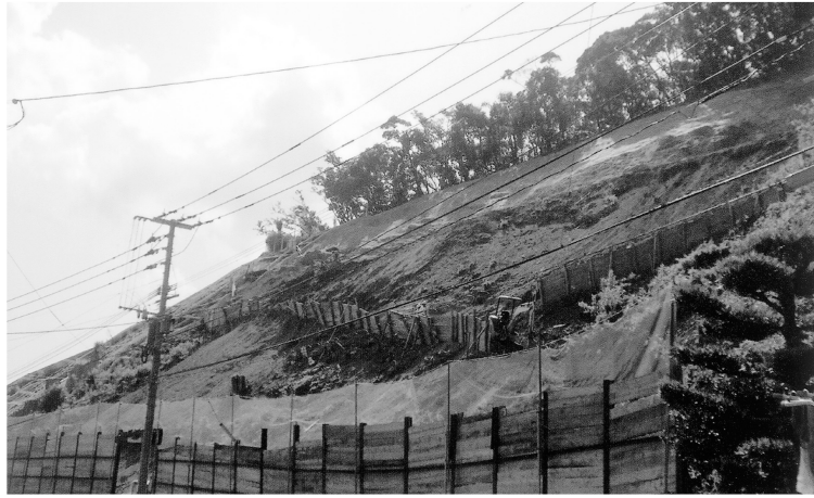
斜面地崩壊のため補修工事が行われている西泊地区
