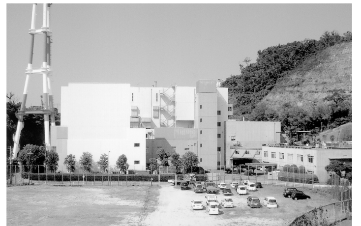
西工場施設整備(工期:平成19年11月～平成20年10月)
