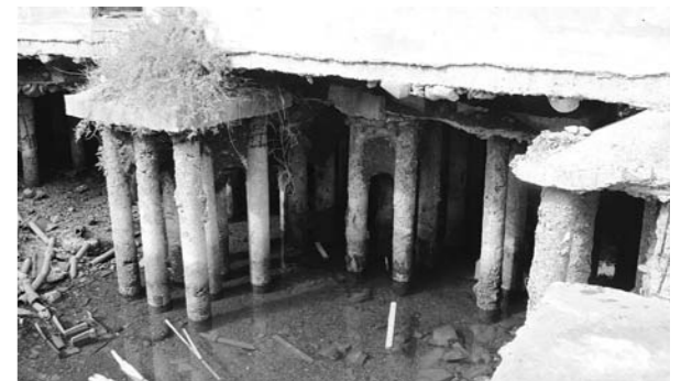
端島炭鉱70号棟下部埋戻し工事
