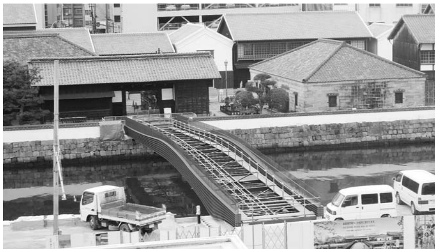
出島表門橋架橋(平成29年3月1日、出島) 11月24日供用開始となる
