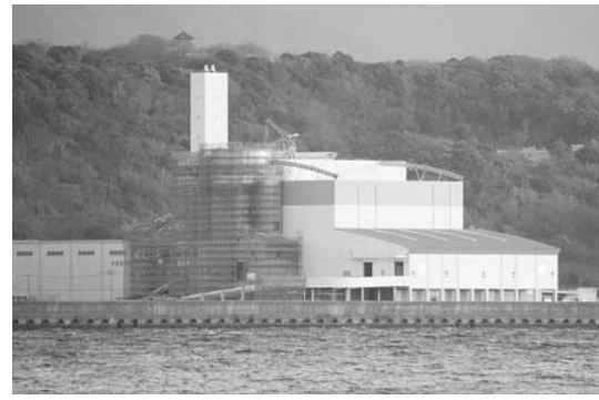
新西工場 試運転開始は7月から!
