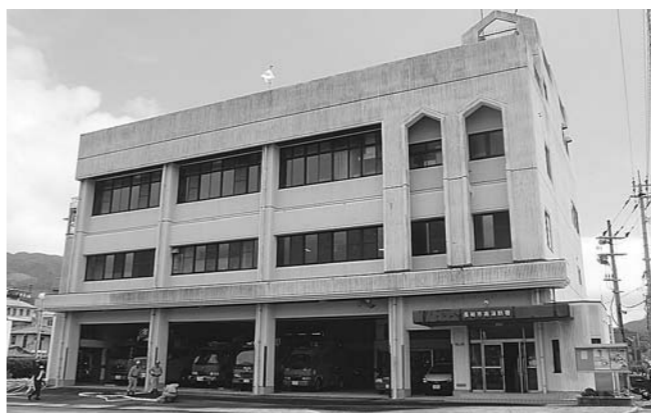
外壁改修予定の南消防署(小ヶ倉町3丁目)
