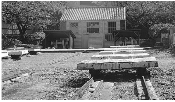
日本初の蒸気機関を動力とする曳揚げ装置が設置された「小菅修船場跡」
