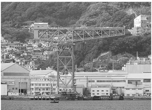
日本で初めて設置された電動起重機、ジャイアント・カンチレバークレーン(三菱長崎造船所)
