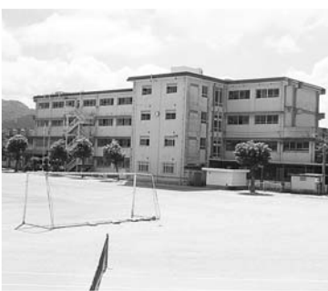
耐震補強工事が実施される福田中学校
