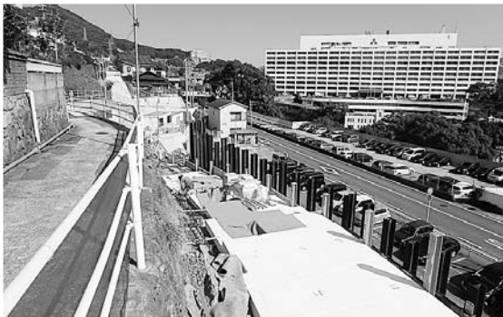
市道岩瀬道町東立神町1号線(写真は岩瀬道町側)
