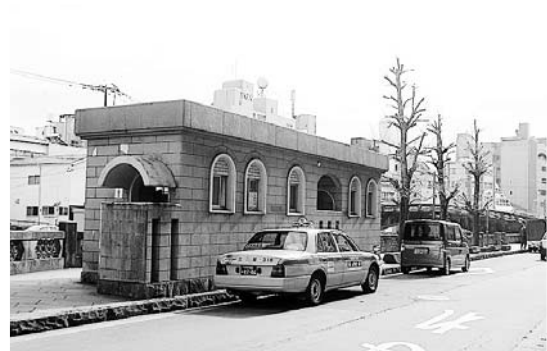
魚の町(市民会館裏) 公衆トイレの改修
