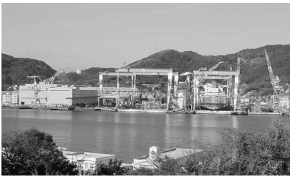
本年より客船連続建造がはじまる長崎造船所(立神工場)
