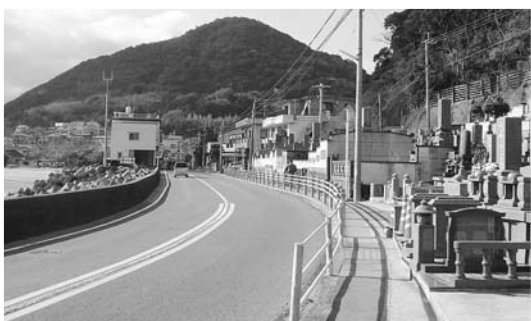
歩行者空間が狭くなっている国道202号 福田本町(墓地付近)
