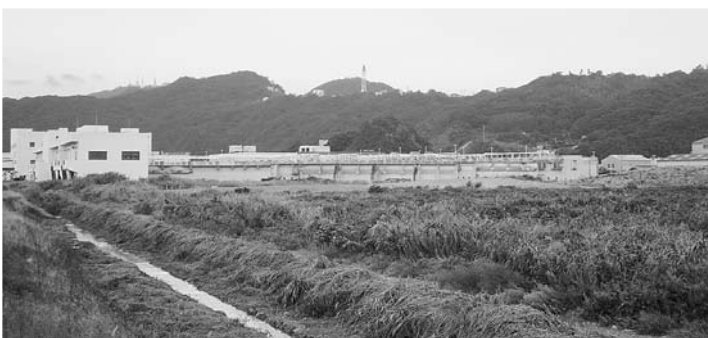
新西工場の建設が予定されている西部下水処理場敷地内(神の島町3丁目)
