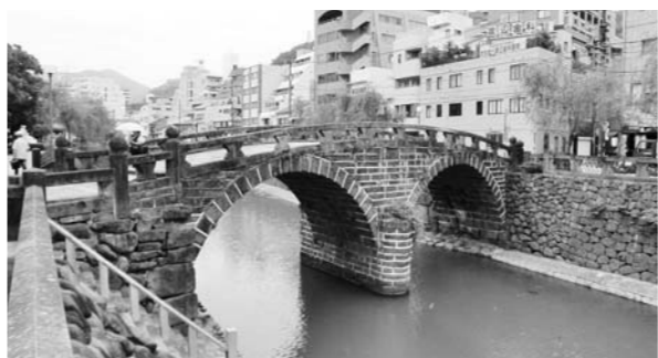
中島川石橋群6ヶ所の老朽化した投光器等をLED化する(写真はめがね橋)
