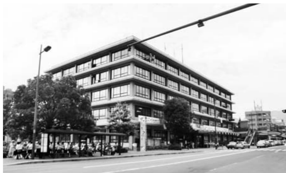
市民懇話会にて建て替えが検討される市役所本庁舎
