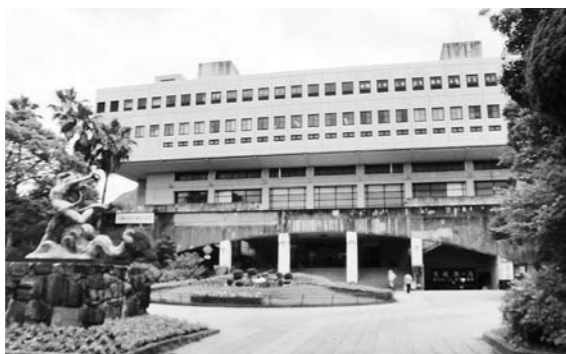
耐震補強工事が予定される市民会館
