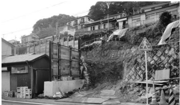
岩瀬道町東立神町1号線の工事がスタート
