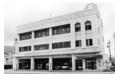
照明器具・空調機器が設置される南消防署
