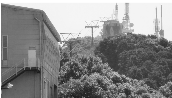
老朽化により使用中止されている稲佐山のスカイウエイ施設の解体および撤去を行う。
