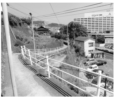
平成22年度から工事予定の岩瀬道八軒家駐車場山側付近
