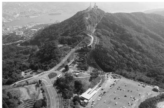
稲佐山公園スロープカー整備
